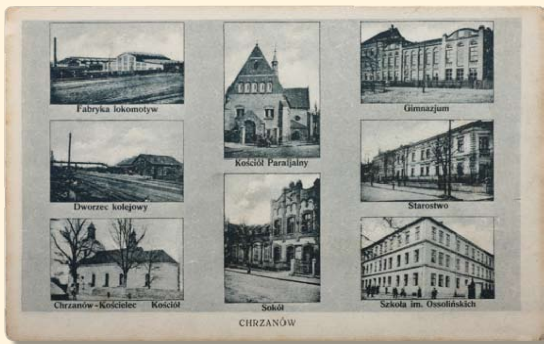
Ryc. 215 Fabryka Lokomotyw, Dworzec kolejowy, Kościół w Kościelecu, Kościół św.Mikołaja w Chrzanowie, „Sokół”, Gimnazjum, Starostwo, szkoła im. Ossolińskich przy ul.Mickiewicza. Wyd. Kazimierz Zarębski, fot. Stanisław Łojek, Chrzanów, 1930 r.
