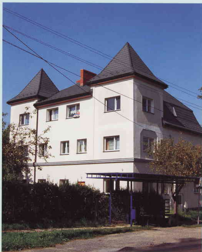
Budynek przy ul. Sobieskiego 45 w Płazie
