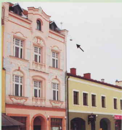
Kamera na budynku Rynek 13
