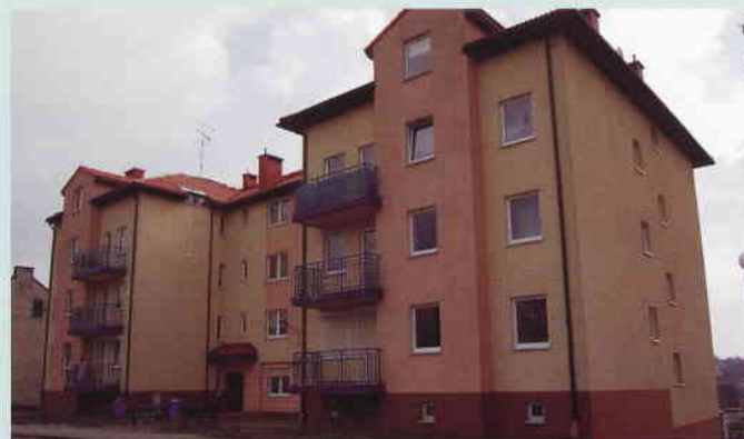
Budynek przy ul. Fabrycznej 29 B
