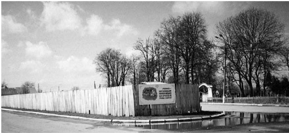
Plac budowy kościoła
