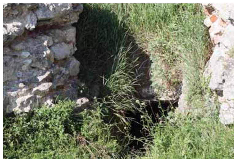
Pozostałości po przejściach podziemnych
