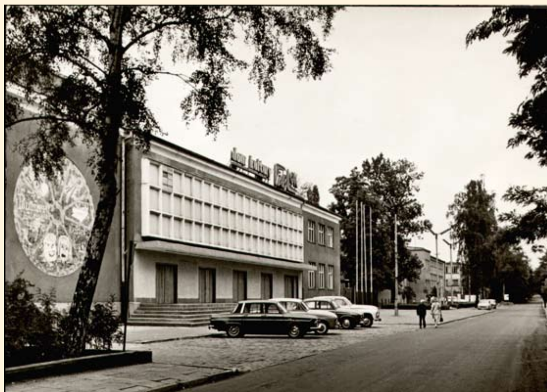
Ryc.157 Dom Kultury „FABLOK”. Wyd. Biuro Wydawniczo-Propa- gandowe, fot. J. Sudecki, 1973 r.
